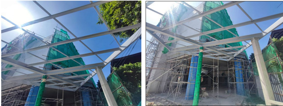
รูปที่ 3.2-3 การติดตั้งตาข่ายกรองแสง (Shading Net) หรือสแลนสีเขียว บริเวณอาคารที่กำลังก่อสร้าง
