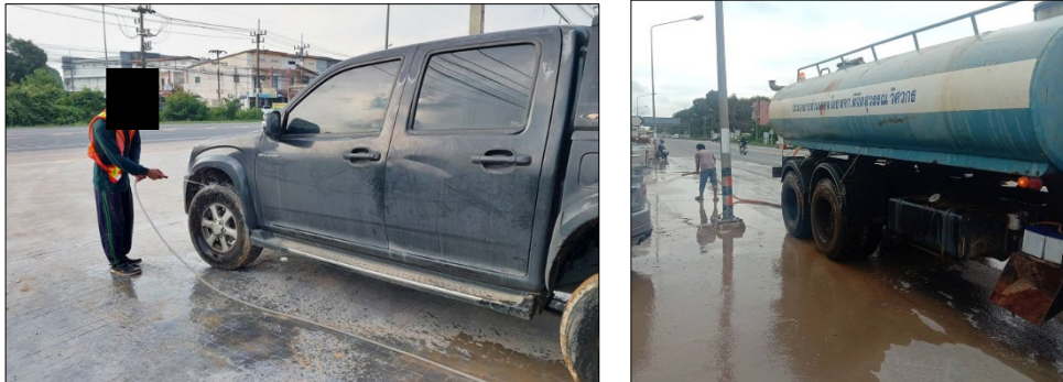
รูปที่ 3.2-6 การล้างล้อรถ และล้างถนนด้านหน้าโครงการ
