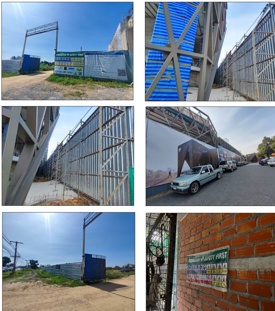
รูปที่ 3.2-1 การจัดทำรั้วและประตูด้านหน้าพื้นที่ก่อสร้าง พร้อมการติดตั้งป้ายเตือน ป้ายประกาศ ระบุชื่อ-ที่อยู่ หมายเลขโทรศัพท์ ที่สามารถติดต่อได้
